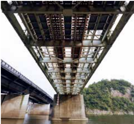
● 犬山橋 (鉄道橋)
